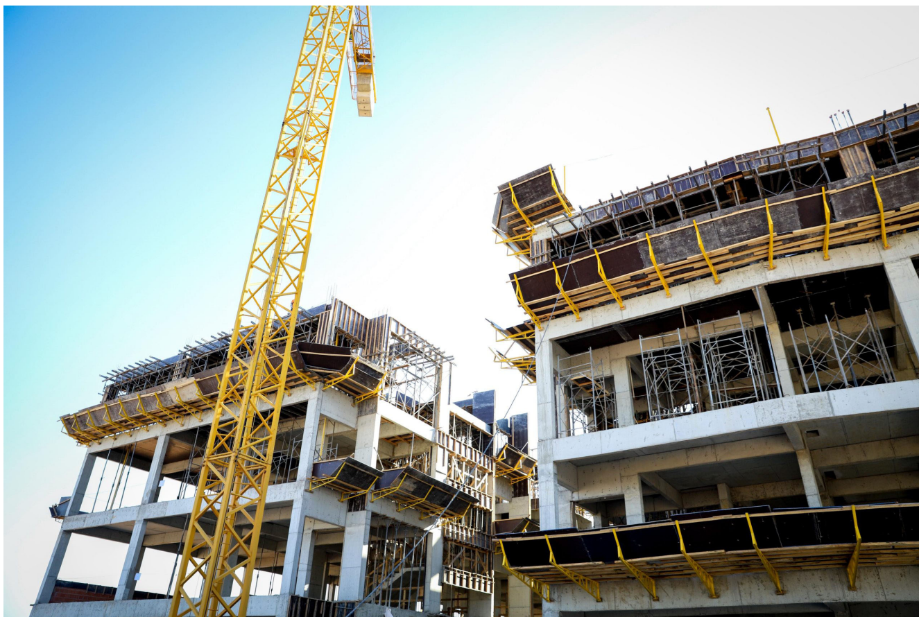
Hospital de São José dos Pinhais segue em obras. Foto: Prefeitura de São José dos Pinhais
